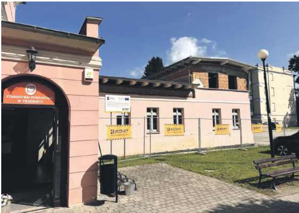
Remont oficyny ma kosztować kilka milionów
