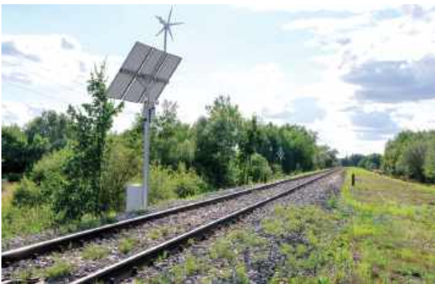
Wiadukt jest stale monitorowany wizyjnie, ale dalej sytuacja jest już inna
