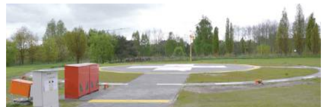
Obok SPZOZ-u zbudowano lądowisko dla helikopterów
