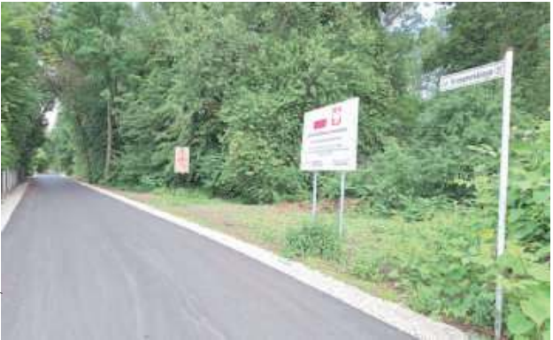
Firma FEDRO wykonała dywanik asfaltowy o grubości 7 cm oraz podbudowę kamienną (28 cm). Zamontowano nowe oznakowanie, uporządkowano pobocza
