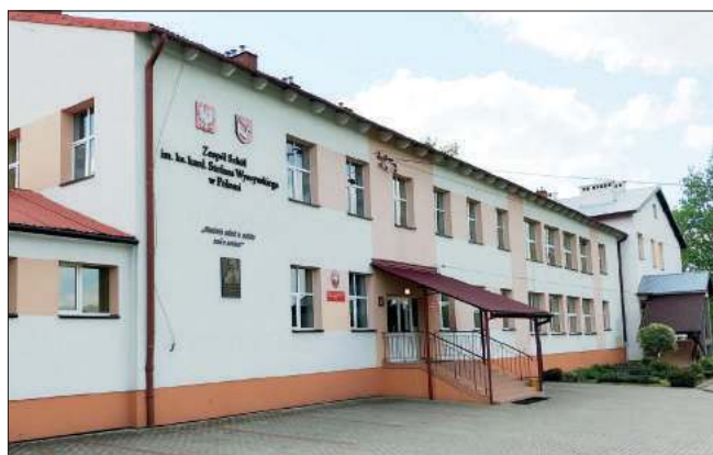
Na termomodernizację budynku Zespołu Szkolno-Przedszkolnego w Połomi wraz z jego remontem gmina pozyskała 7,45 mln zł.
