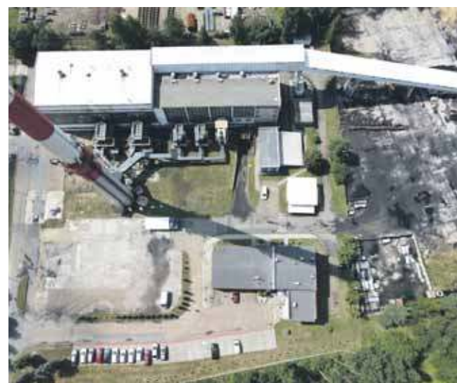
System kogeneracyjny zasilany gazem ziemnym, biomasą leśną i biogazem z lokalnej oczyszczalni ścieków powstanie na placu (z lewej strony zdjęcia), który obecnie wykorzystywany jest do parkowania
