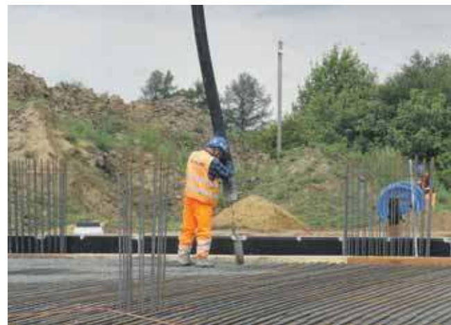
Nowe, przestronne garaże bardzo się strażakom przydadzą. Fundamenty już są
