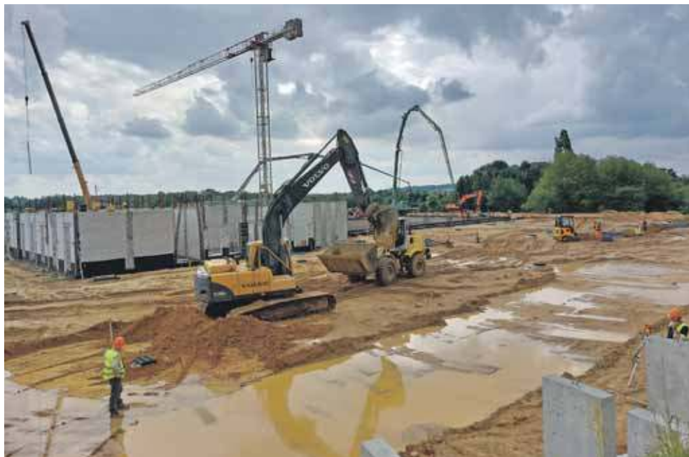
Stoją już ściany parteru komendy, wylano betonową płytę fundamentową pod garaże
