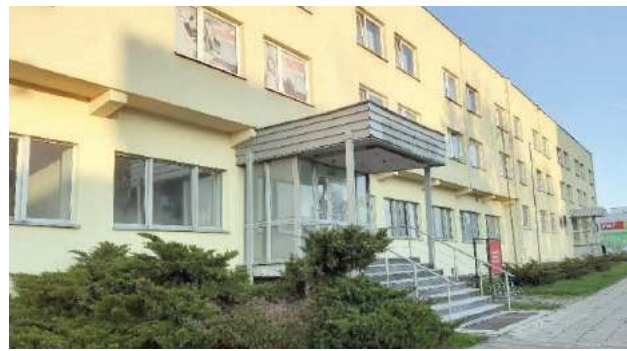
Remont pomieszczeń przy ul. Wyszyńskiego 52 został już zakończony. Dyrekcja „dwójki” czeka na wyposażenie.
