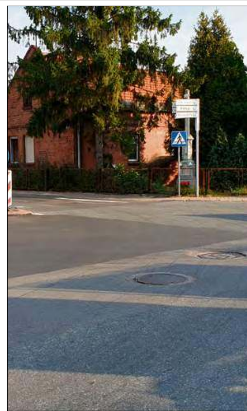
I po remoncie...
