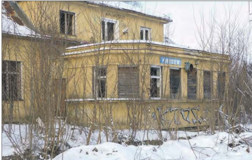
✚ Kiedyś to miejsce tętniło życiem przyjmując pasażerów. Dziś to rozpadająca się ruina
