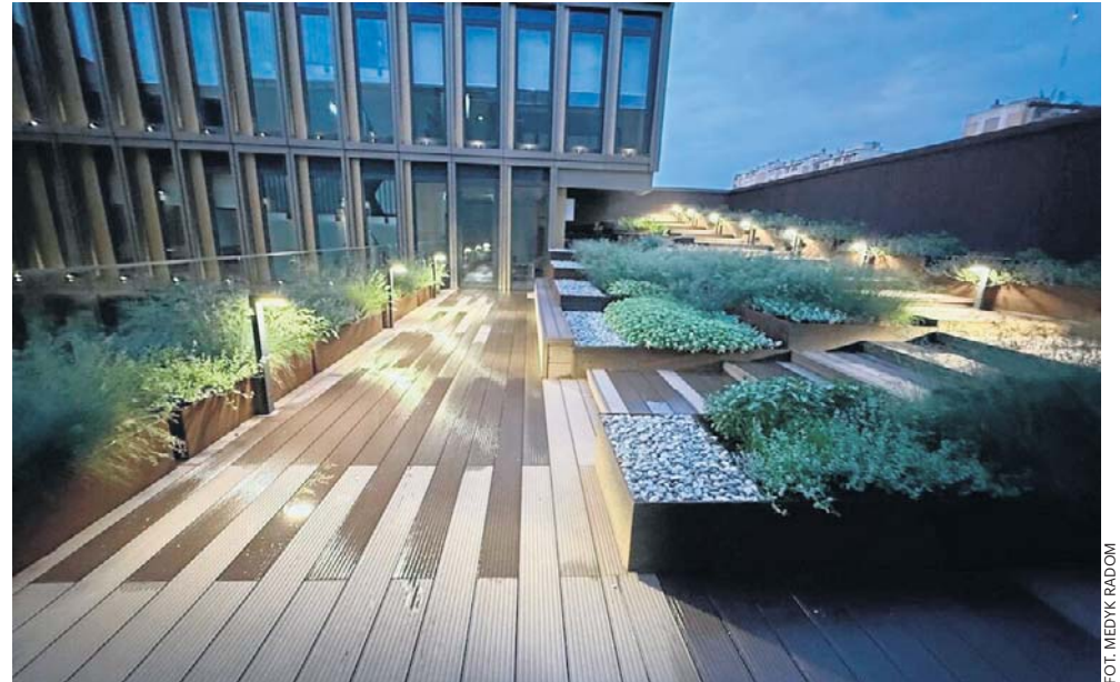
Na dachu nowej części Medyka, czyli Centrum Kształcenia Zawodowego i Ustawicznego w Radomiu, jest nawet ogród z miejscem do relaksu.
