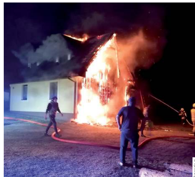
Jedna ze ścian domu w Okalu spaliła się całkowicie. Rozebrać trzeba będzie także nadpalony w dużej części dach
