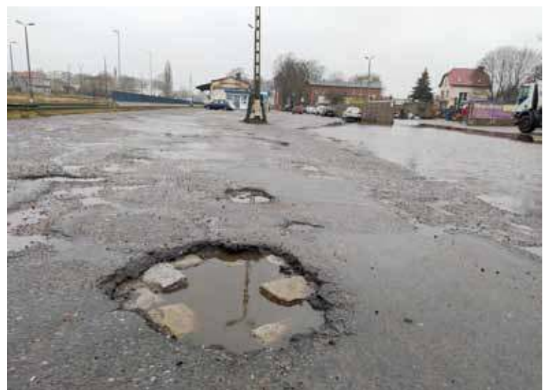
Łącznik Dworcowa - 700-lecia czyli miejsce o ogromnym potencjale podatkowym nie może się doczekać od lat decyzji radnych o inwestycji infrastrukturalnej pozwalającej ten potencjał uruchomić, czyli wykonać inwestycje planowane tu przez prywatnych właścicieli działek, od których wpłyną do kasy gminnej podatki i opłaty. I nie trzeba na to wielkiej wyobraźni...
