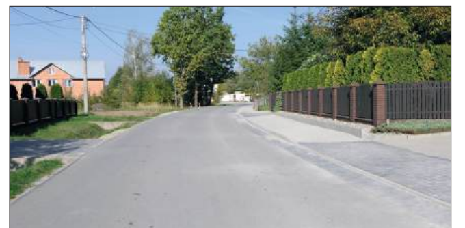
Nowy odcinek chodnika przy drodze powiatowej Trześń – Domatków – Bukowiec – Kupno, w Zapolu.
