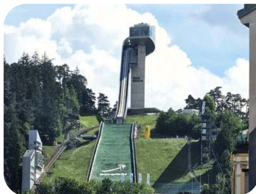
Skocznia narciarska na Bergisel mistrzowsko łączy w sobie most, budynek i stalową konstrukcję zaprojektowaną przez iracką architektkę Zahę Hadid. Arena Bergisel jest miejscem corocznego Turnieju Czterech Skoczni
