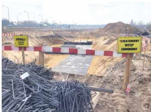
Wykopy pod fundamenty obiektów mostowych
