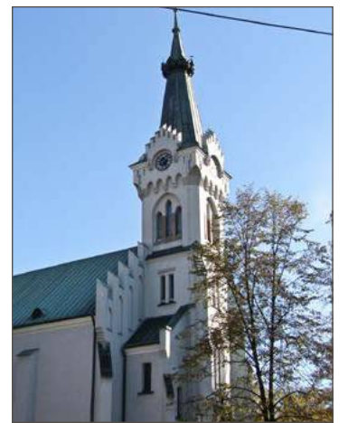
Kościół św. Jadwigi to jeden z niewielu dębickich zabytków.
