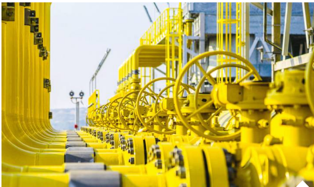
Zadanie związane z zapewnieniem bezpieczeństwa gazowego Polski zostało zrealizowane | fot. mat. pras./d
