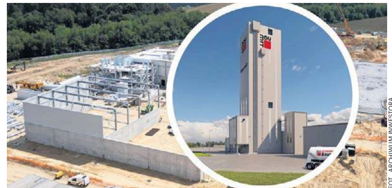
Budowa nowego zakładu produkcyjnego pochłonie ok. 100 mln zł.
