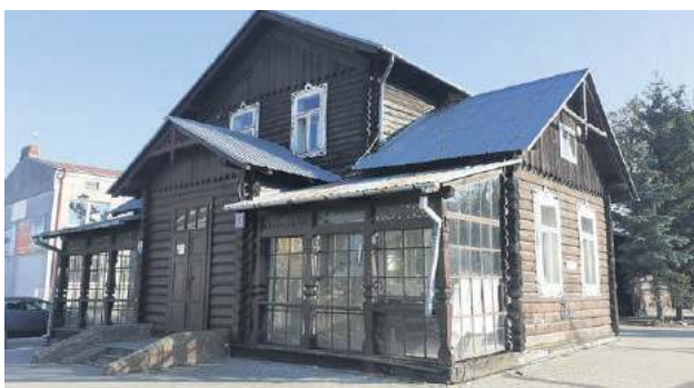
Banery szpeczące elewację usunięto.
