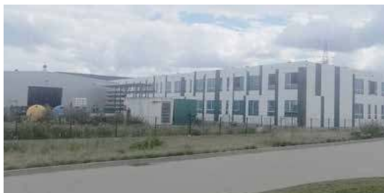
Dobiega końca budowa hotelu k. ZAZ na terenie GPP, tu też gmina chce na dachu postawić panele fotowoltaiczne, aby sam ZAZ płacił mniej za prąd, a nadwyżki energii były sprzedawane właścicielowi obiektu
