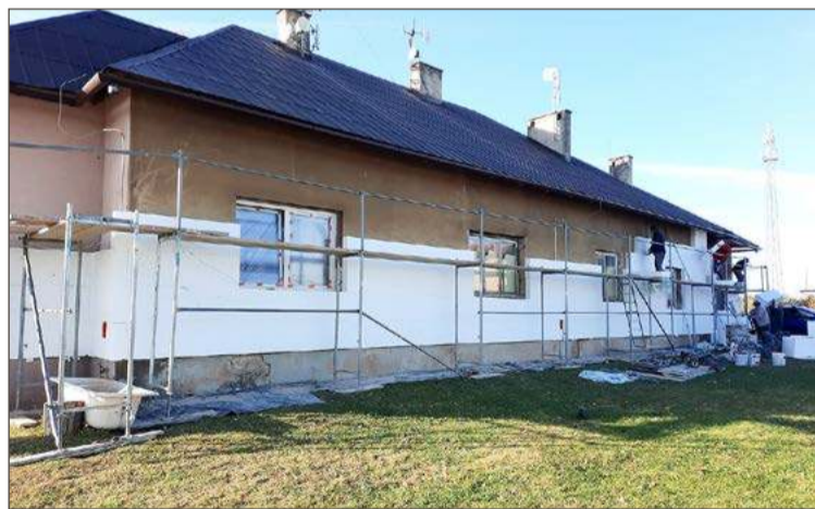
W poprzedniej kadencji Dom Ludowy w Gorzejowej doczekał się gruntownego remontu. Teraz czekają go kolejne zmiany. Fot. Arch.
