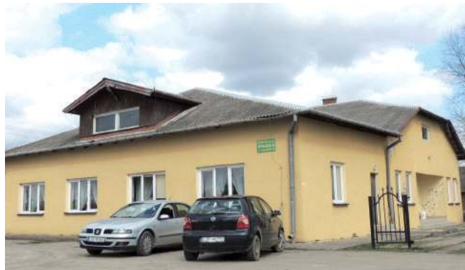
Świetlica w Kłodnicy ostatni raz była remontowana w 2010 roku. Mieszkańcy się cieszą, że po latach czekania w końcu zostanie wymieniony na budynek dach
