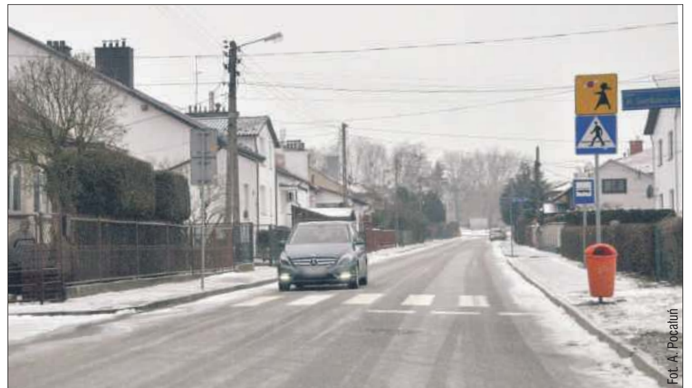
Mieszkańcy ul. Wojska Polskiego w Kolbuszowej od dawna proszą o wybudowanie progów spowalniającego ruch z kostki brukowej w miejscu obecnego przejścia dla pieszych.
