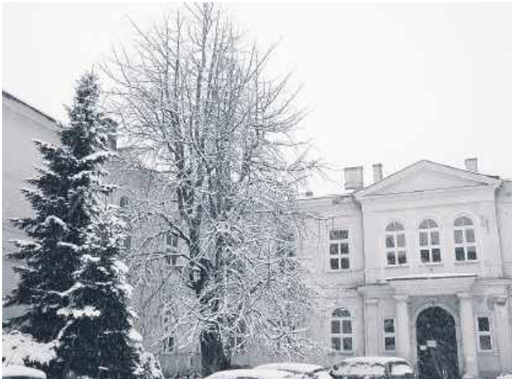
Budynek szkoły. Miłorząb rosnący na placu szkolnym jest pomnikiem przyrody
