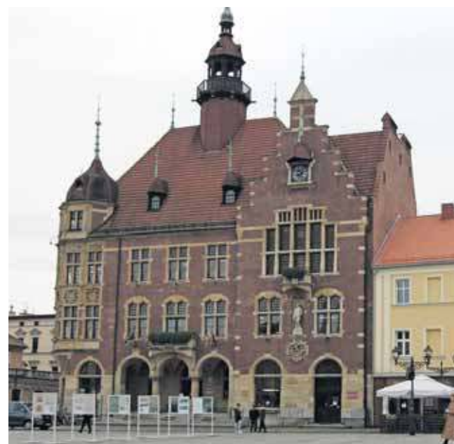
Prace remontowe mają trwać 2 lata
