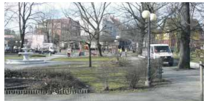
Prace przy placu TPD już trwają i toaleta ma być gotowa jeszcze w tym roku
