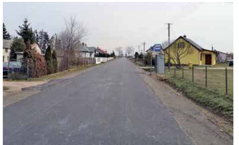
Fragment zmodernizowanej drogi
