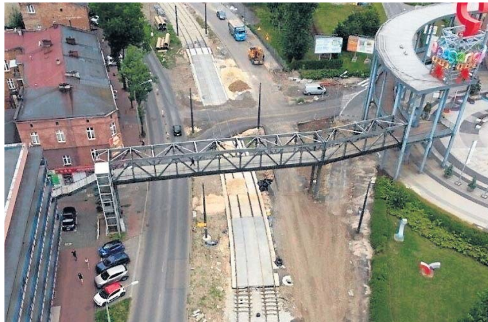
Kładka prowadząca do Centrum Handlowego Pogoria w Dąbrowie Górniczej została rozebrana latem 2024 r. To była spektakularna operacja
