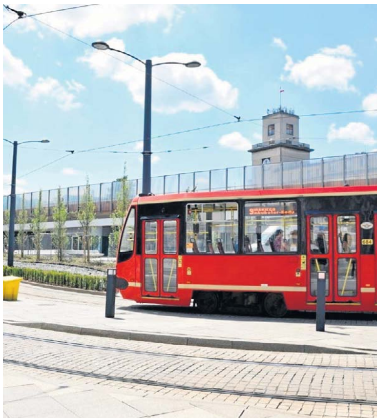
Tramwaje wracają na estakadę w Chorzowie
