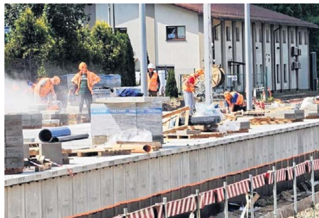
Przebudowa stacji Sosnowiec Główny
