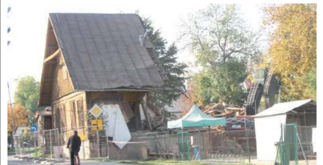
Drewniany dom przy ul. Kościuszki został już rozebrany
