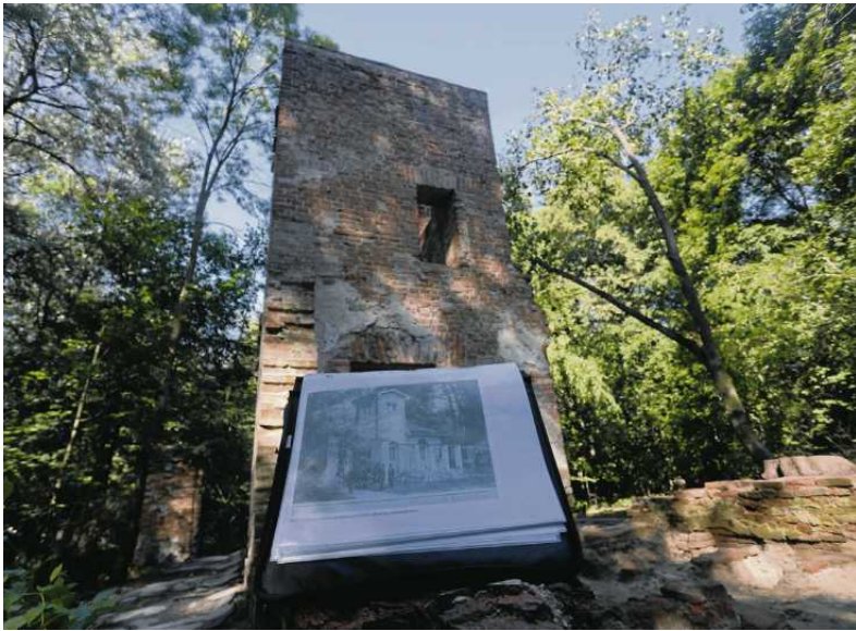
• Zabytkowe ruiny Domu Stróża w Morysinie. Na pierwszym planie ilustracja przedstawiająca dawny widok tej budowli
