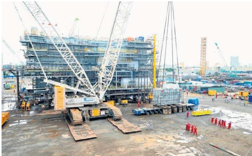
Montaż pierwszego transformatora na stacji dla farmy wiatrowej Baltica 2
