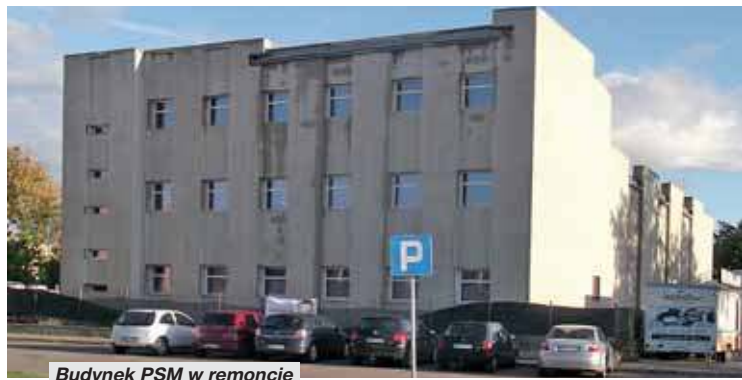
Budynek PSM w remoncie
