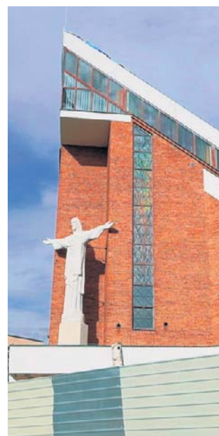
Trwają prace nad projektem przebudowy kościoła
