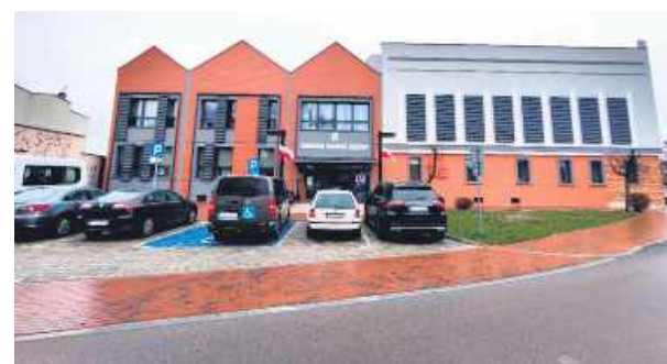
Po wykonaniu termomodernizacji obiekt zmienił się nie do poznania.
