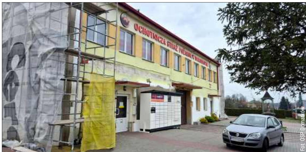
Remiza jest w trakcie termomodernizacji.
