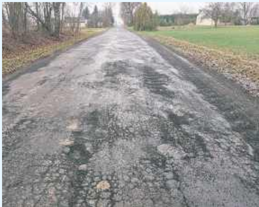
Tak wyglądała droga przed remontem
