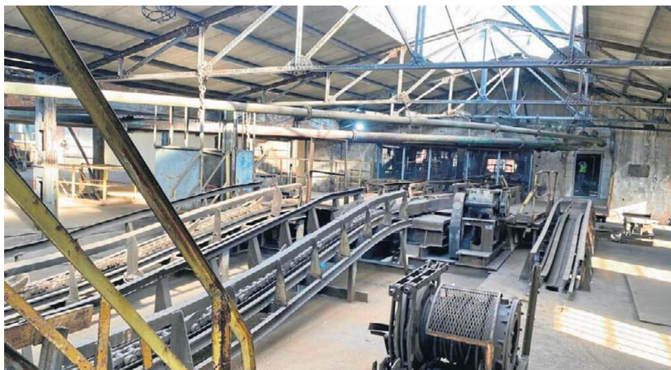
Wyczyszczono już maszyny i przestrzenie, które będziemy oglądać, gotowy jest dach sortowni i konstrukcja klatki komunikacyjnej.
