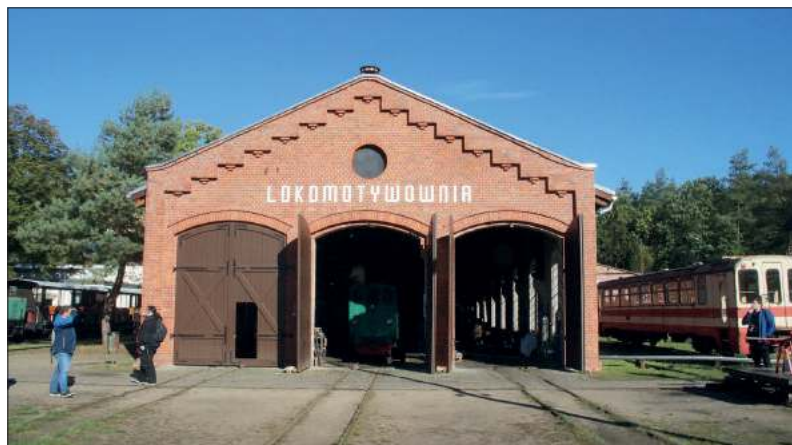
Prace remontowe objęły przeprowadzenie remontu budynków wagonowni, lokomotywni i budynku stacyjnego oraz przebudowę pomieszczeń garażowo-magazynowych na salę kinową i szkoleniową. Konkretnie wymieniono pokrycie dachowe wraz z jego ociepleniem; umyto elewację, dzięki czemu cegła odzyskała swój naturalny kolor; wymieniono bramę wjazdową do lokomotywni oraz przystosowano wagonownię do organizacji wystaw. Kapitałnemu remontowi został poddany również budynek dworcowy, w ramach którego wymieniono stolarkę okienną i drzwiową. Wymieniono również pokrycie dachowe wraz z ociepleniem, przeprowadzono wymianę instalacji wodnej, kanalizacyjnej, elektrycznej i centralnego ogrzewania. Na zdjęciach: obecny wygląd lokomotywni i budynek dworcowy.
