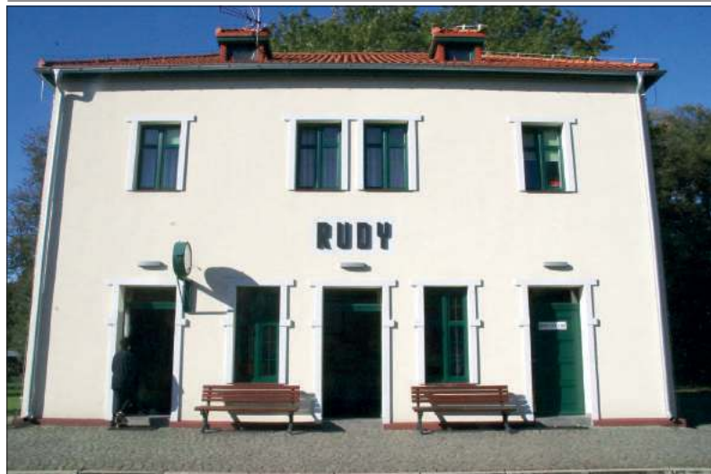
Prace remontowe objęły przeprowadzenie remontu budynków wagonowni, lokomotywni i budynku stacyjnego oraz przebudowę pomieszczeń garażowo-magazynowych na salę kinową i szkoleniową. Konkretnie wymieniono pokrycie dachowe wraz z jego ociepleniem; umyto elewację, dzięki czemu cegła odzyskała swój naturalny kolor; wymieniono bramę wjazdową do lokomotywni oraz przystosowano wagonownię do organizacji wystaw. Kapitałnemu remontowi został poddany również budynek dworcowy, w ramach którego wymieniono stolarkę okienną i drzwiową. Wymieniono również pokrycie dachowe wraz z ociepleniem, przeprowadzono wymianę instalacji wodnej, kanalizacyjnej, elektrycznej i centralnego ogrzewania. Na zdjęciach: obecny wygląd lokomotywni i budynek dworcowy.
