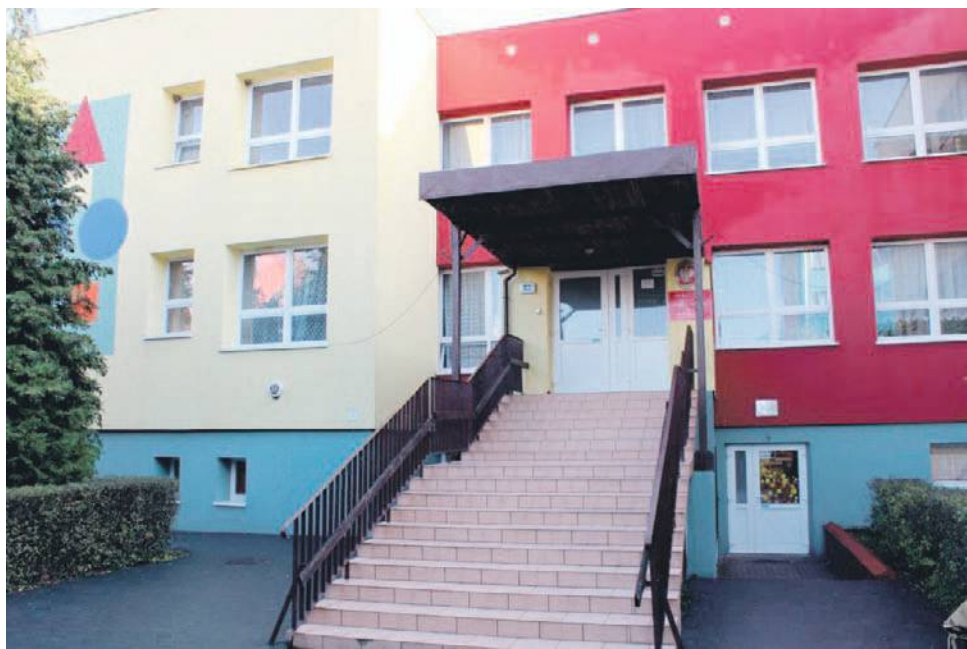
Jedną ze szkół w powiecie oławskim, przy których mają powstać nowe hale, jest Publiczna Szkoła Podstawowa nr 3 w Jelczu-Laskowicach. Chodzi o budynek przy ul. Hirszfelda
