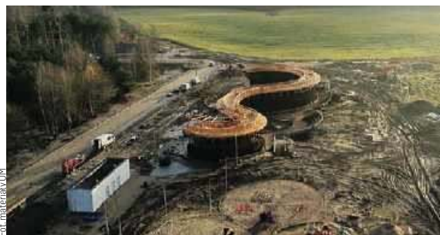
Trwa budowa dużej tężni solankowej w kształcie ślimaka
