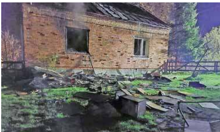
Rodzina cudem ocalała dzięki czujności Justyny, mamy dzieci. Domownicy w ostatniej chwili opuścili płonący budynek. W domu mieszkało 6 osób
