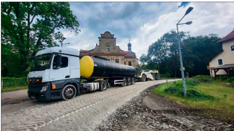
Remontowany odcinek ul. Kościuszki w Turawie ma zyskać nową nawierzchnię i służyć kierowcom przez kolejne lata.
