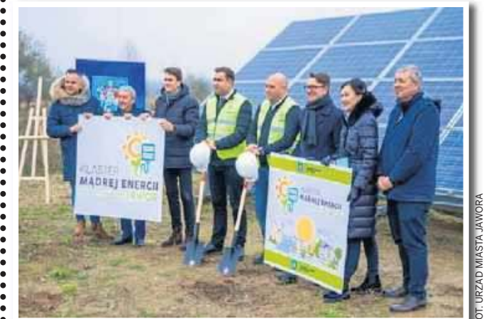
Budowa farmy rozpocznie się lada miesiąc, a do końca 2023 roku ma już popłynąć prąd - obiecuje wykonawca
