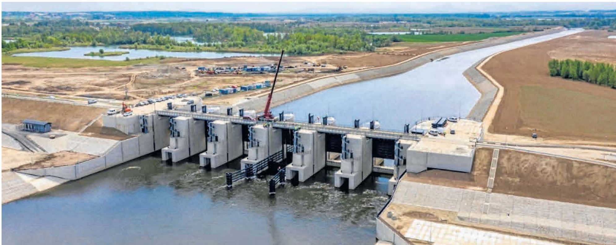
W przypadku nadejścia fali powodziowej przepływ wody kontrolować ma 6 zasuw. Zbiornik może pomieścić 185 mln m sześć. wody. Długość wałów wynosi ponad 22 kilometry
