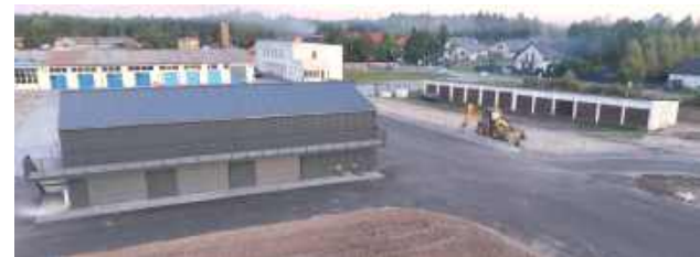
Autodrom to obecnie plac budowy
