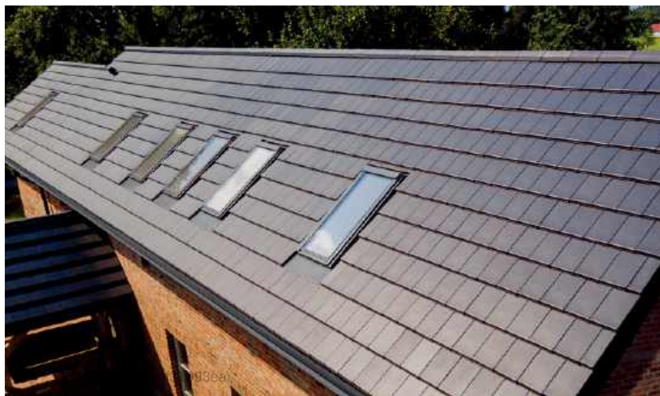
📍 Płaskie dachówki ceramiczne, w formacie 300 x 500 mm, mogą być ułożone nawet na dachach o nachyleniu zaledwie 10°. Warunkiem jest jednak wykonanie odpowiednio szczelnego podkładu. CREATON POLSKA
