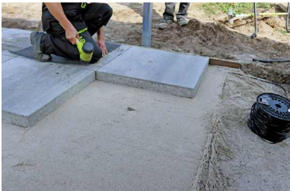
🔧 Płyty tarasowe układane na podbudowie. LIBET
