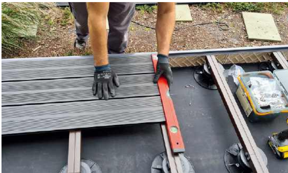
Deski kompozytowe na wspornikach, czyli taras wentylowany. RENOPLAST
