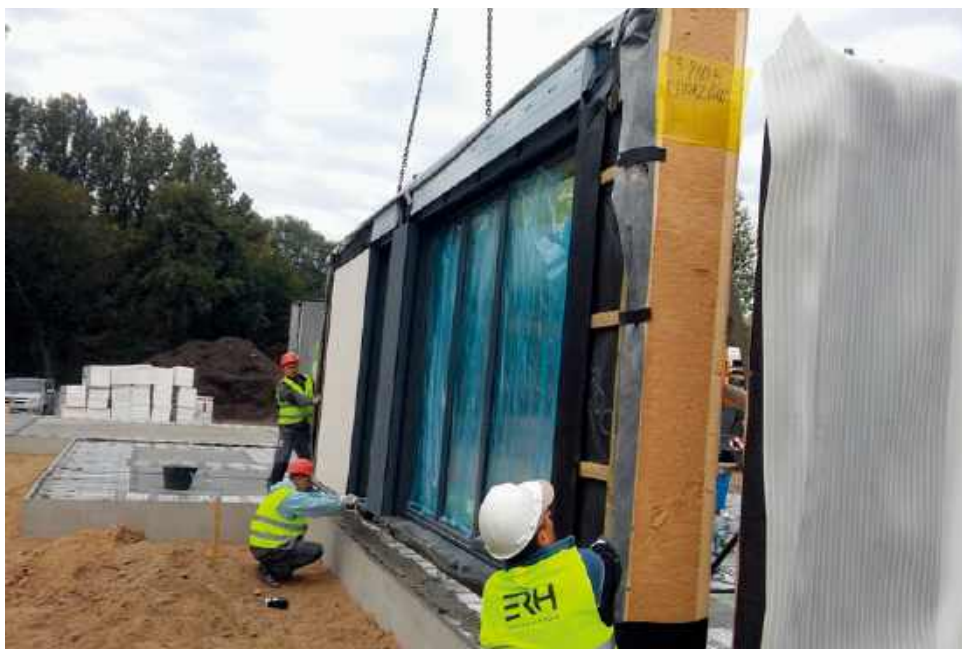
🔗 Prefabrykatami mogą być całe, niemal gotowe ściany. SAINT GOBAIN (ECO READY HOUSE)
