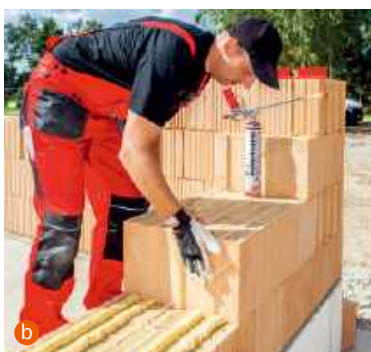
➊ Elementy murowe łączy się dziś nie tylko tradycyjnie, lecz także zaprawą do cienkich spoin (a XELLA) i poliuretanową pianą z puszk (b WIENERBERGER).
