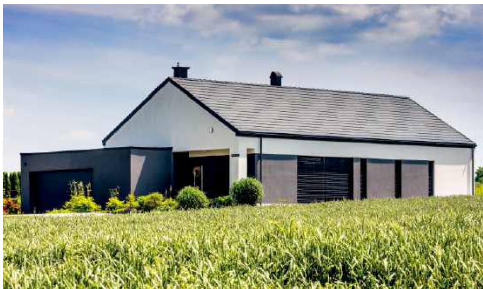
📍 Dachówki betonowe są tańsze od ceramicznych. Jest to związane z mniej energochłonnym procesem produkcji, do którego nie jest potrzebna bardzo wysoka temperatura. BMI BRAAS
