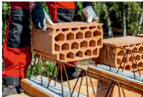
🔦 Strop gęstożebrowy tworzą belki, między którymi ręcznie układa się pustaki. WIENERBERGER
