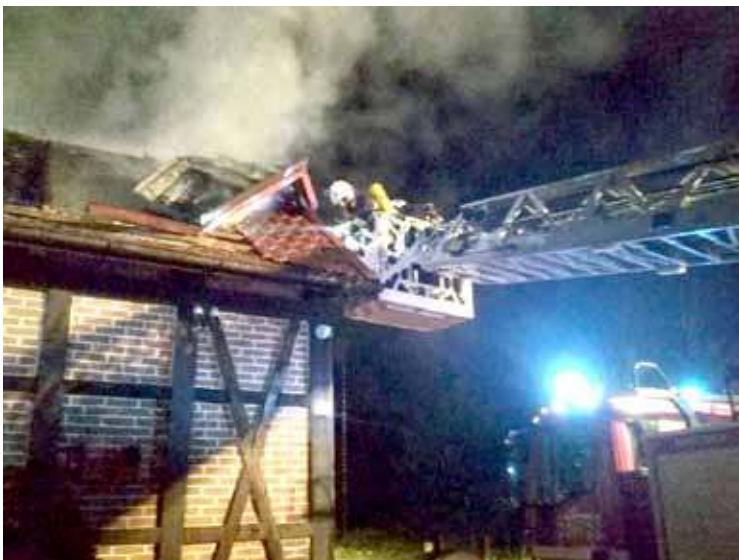
W wyniku pożaru spłonęła spora część dachu oraz poddasze budynku. Foto. OSP Bielkowo
