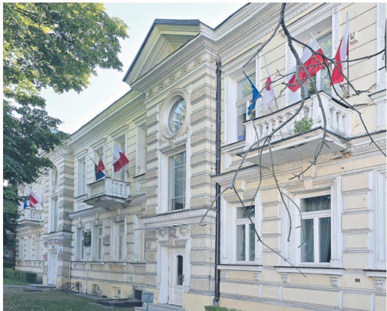
Budynek prosi się o remont.
