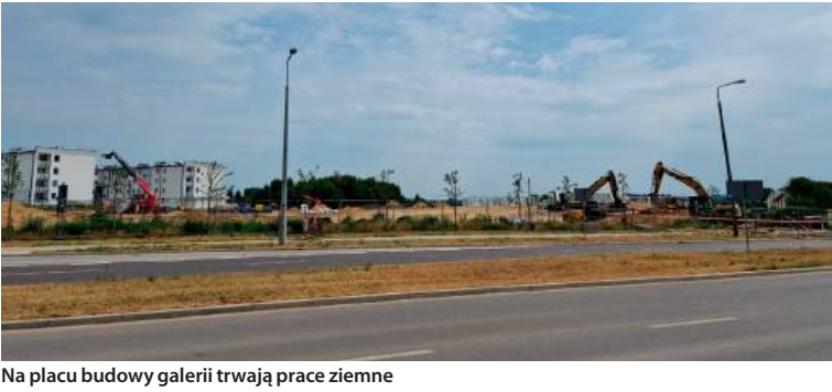
Na placu budowy galerii trwają prace ziemne
