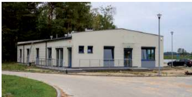
Foto: Budynek hangaru nad zalewem Zimna Woda.
