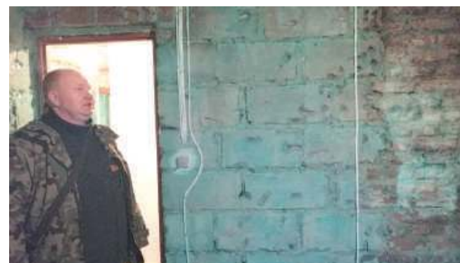
- Brakuje jeszcze tynków i podłóg, ale mieszkać już można - mówi Rafał Iwanek
